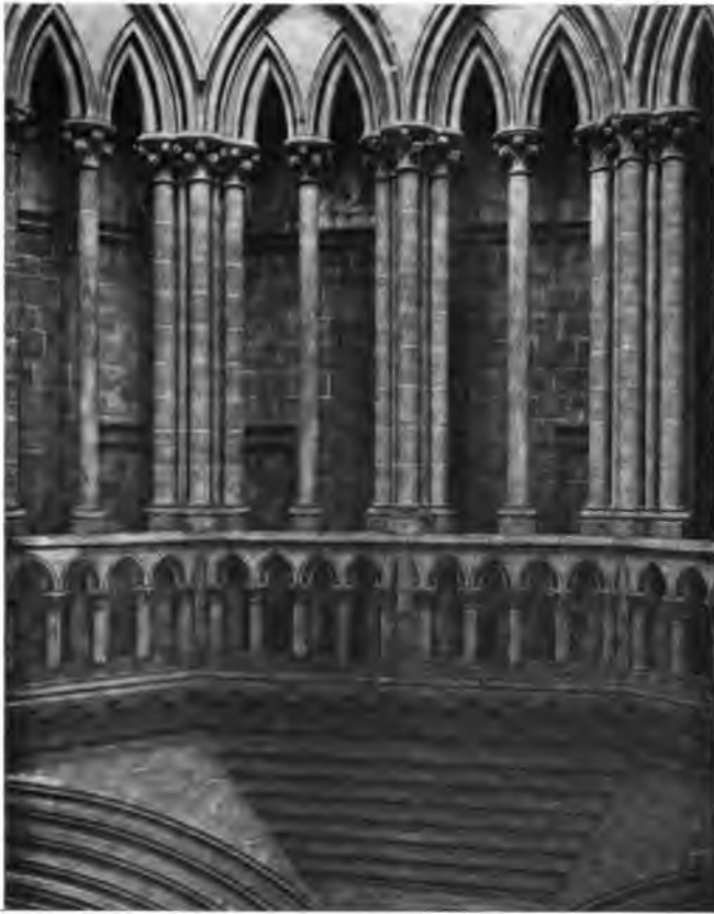
Fig. 112. — Appui intérieur au départ de la « Tour lanterne » du transept à la cathédrale de Coutances ; arcatures évidées dans des dalles.
